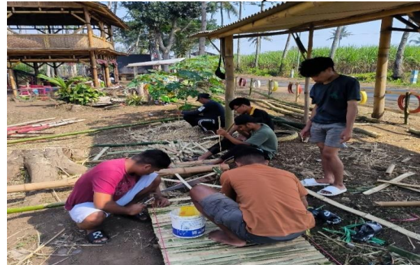
Gambar 1. Proses Rehabilitasi Infrastruktur Taman Desa Sutojayan
