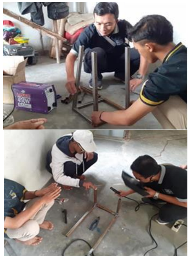
Gambar 6. Penyiapan material hingga tahap tack-weld
