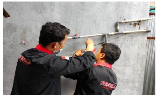
Setelah pemasangan filter air, tahap berikutnya adalah uji coba filter air. Sehingga dapat diketahui air bisa mengalir melewati filter air karbon aktif atau tidak. Hasil pemasangan
